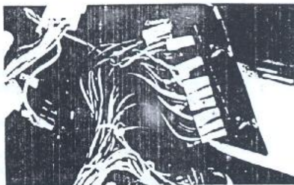
Figura 9.37.1 - Terminais elétricos da caixa de fusíveis
